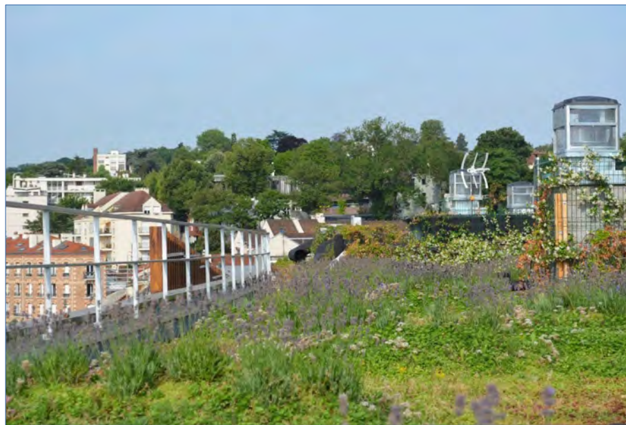
Réalisation EcoVégétal sur une toiture à Sèvres..
