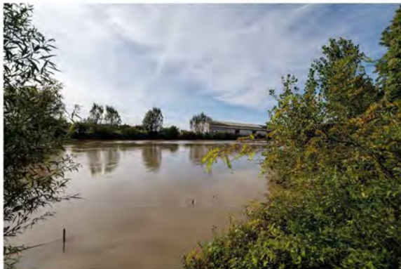
ÉTAT ACTUEL (AVANT DÉMOLITION)
