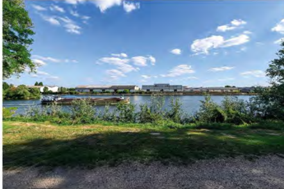
ÉTAT ACTUEL (AVANT DÉMOLITION)
